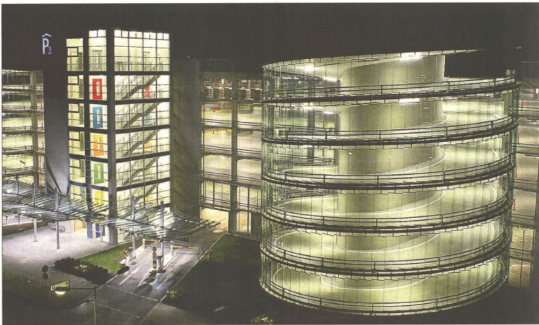
Das neue Nürnberger Flughafen-Parkhaus bietet auf 60 000 Quadratmetern 2144 Pkws Platz.
