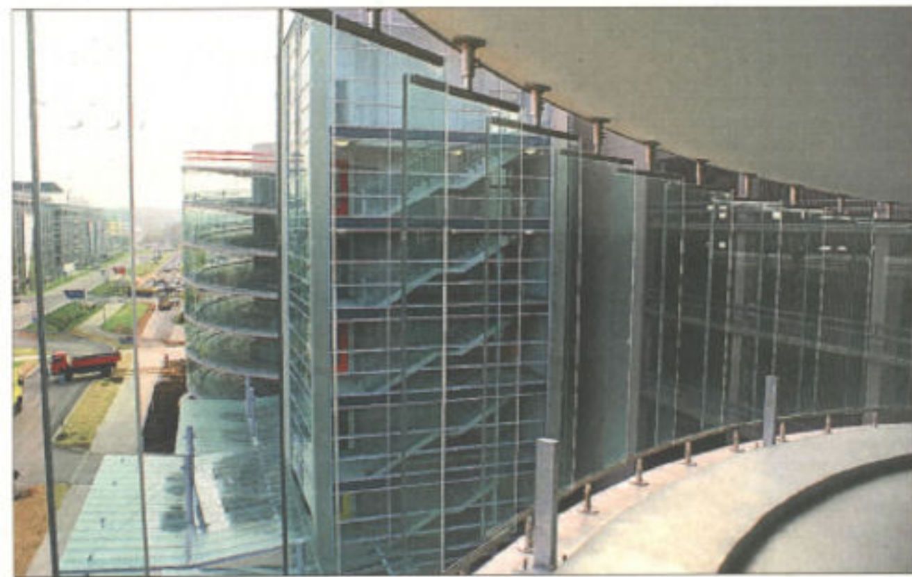
Das P 3 erstreckt sich über sieben Parkdeckebenen.
